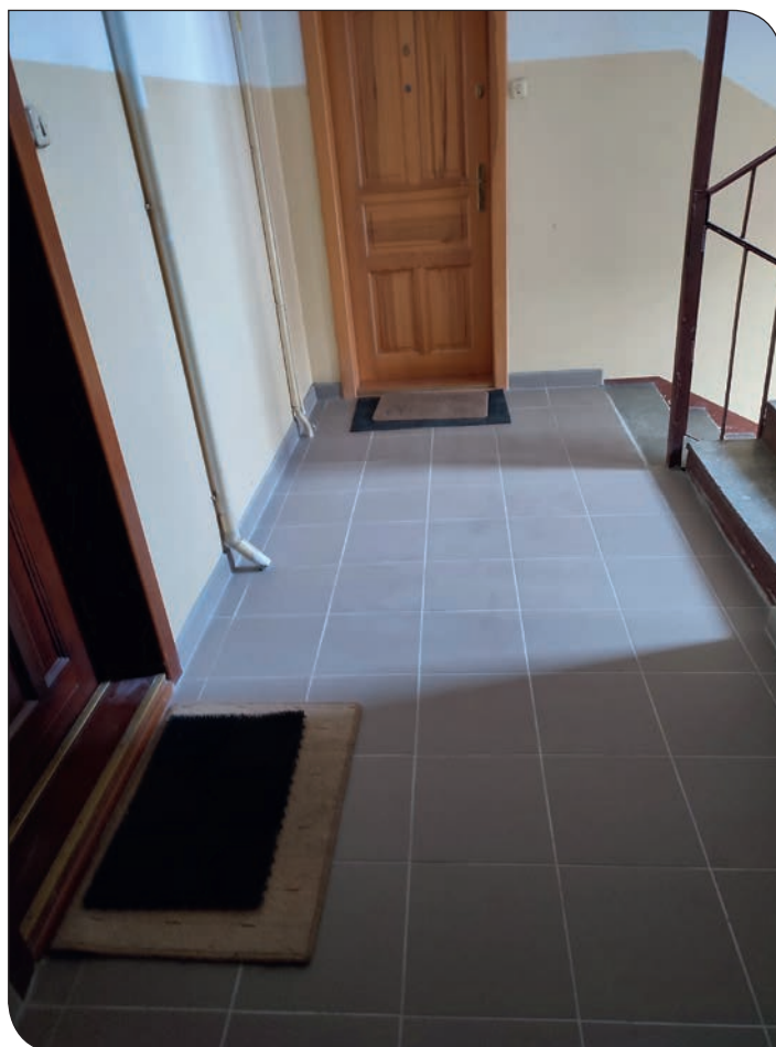
os. Różane 21 - po położeniu płytek ceramicznych
