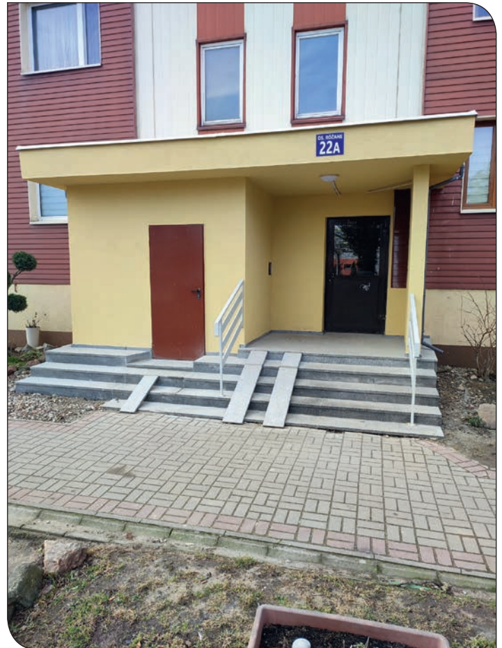
po remoncie - wejście os. Różane 22A
