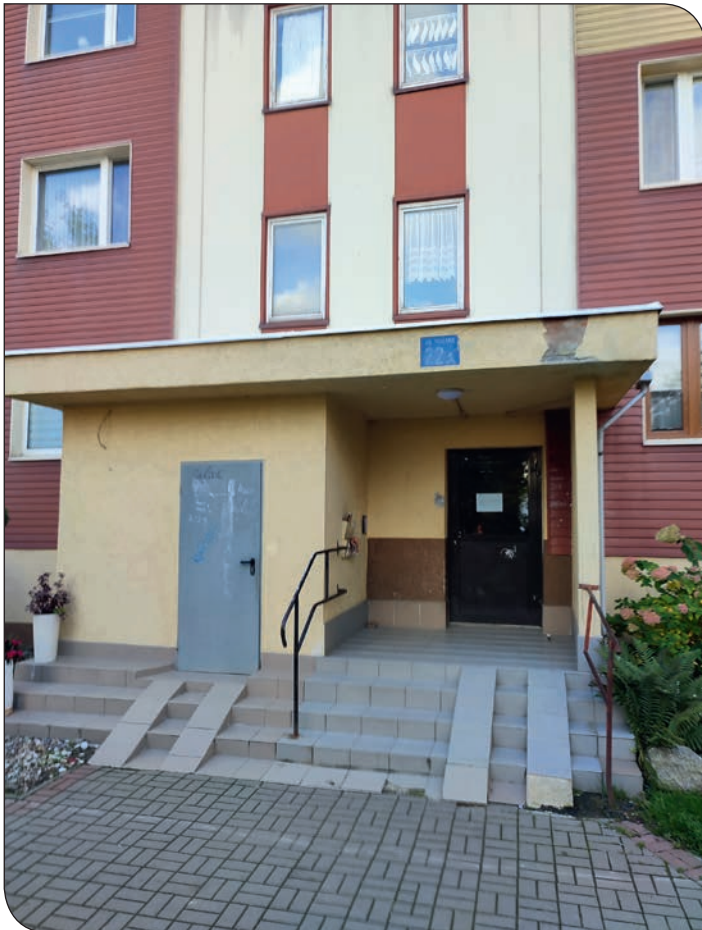
przed remontem - wejście os. Różane 22A
