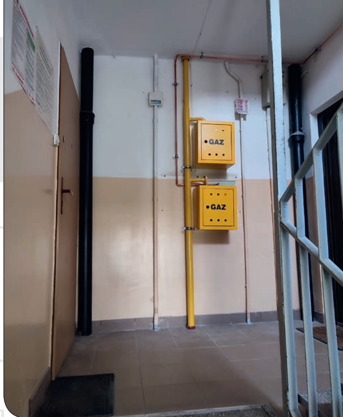
os. Różane - po wymianie instalacji
