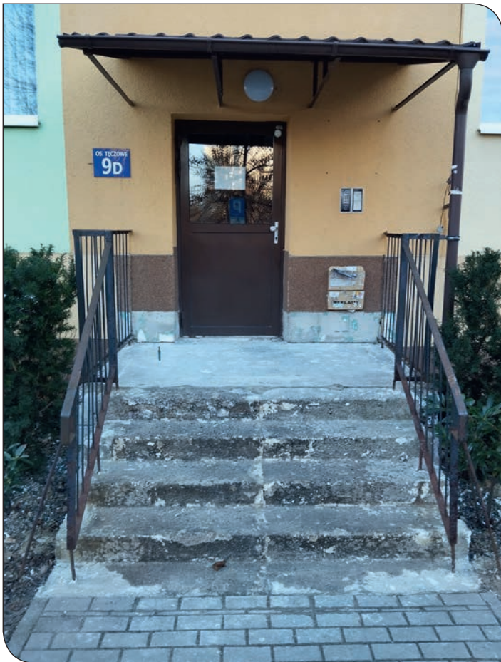
os. Tęczowe 9 - schody w trakcie remontu
