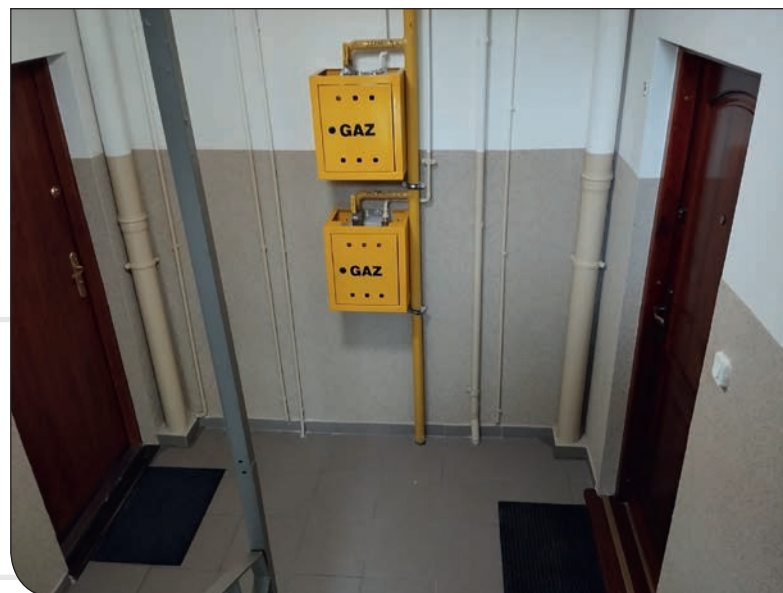
os. Błękitne 20 - po remoncie klatki schodowej
